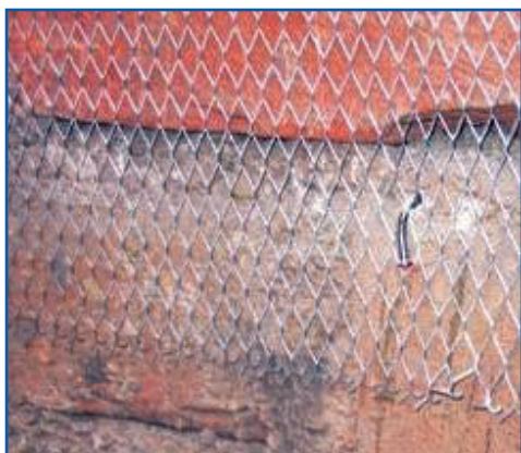
Malla colocada preparada para recibir el tarrajeo.
