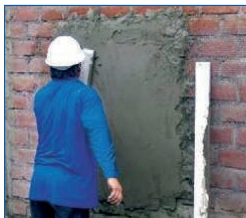
Tarrajeando sobre la malla fija.
