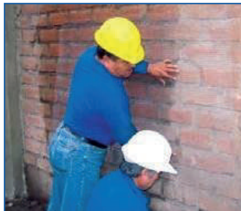
Fijando con clavos la malla para tarrajeo.
